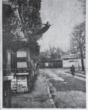
Le peintre de l'espace se jette dans le vide !
