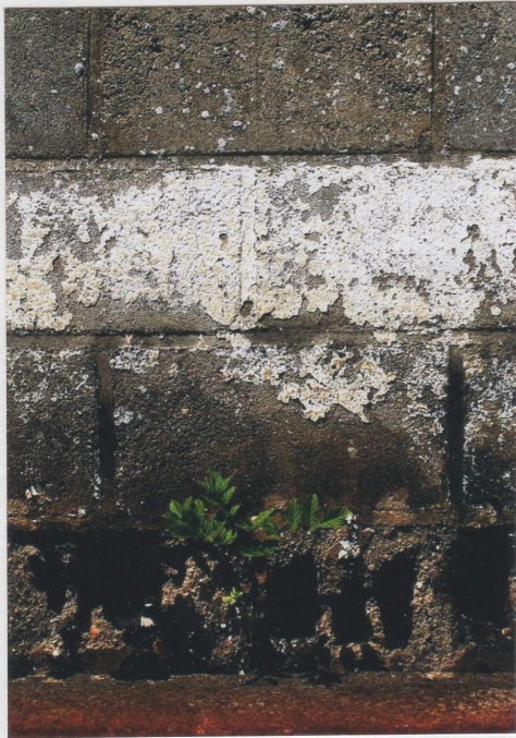
Un ATC de: Christian Alle, 9 rue du Pré de la Mer, 50460, Urville-Nacqueville, FRANCE
