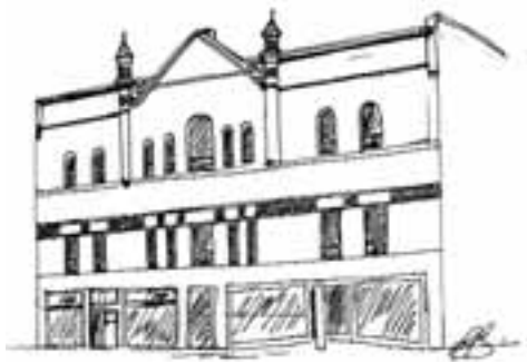
Édifice Rosenbloom logeant boutique Réjan Mode, bureaux et logements 134, rue Wellington Nord Année(s) de construction : 1896; agrandissement en 1902 et 1922
